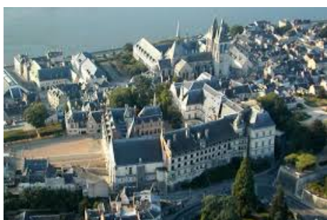
Vue générale du château
