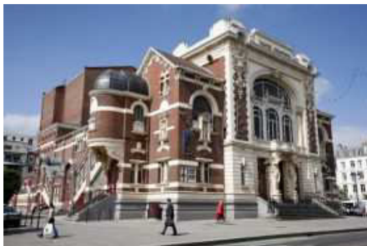
La Maison Coilliot
